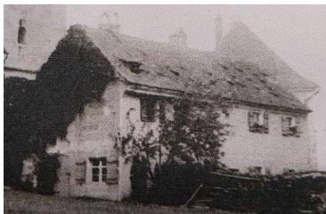
Der Backofen mit dem Wächterhaus 1925. Hier sind die Dachgaube und die Kaminhaube auf dem Wächterhaus zu erkennen. Die Dachziegel auf dem Wächterhaus sind zum Trocknen des Tabaks aufgestellt. An der Südwand des Backofens wächst ein Spalierbaum.
